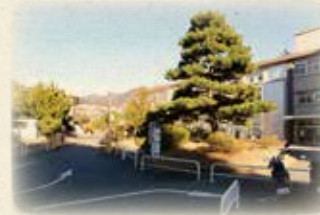
現在のB1号館 雰囲気が変わりましたが原型をとどめています。B1号館。何かが増えたのですが…わかりましたか？
